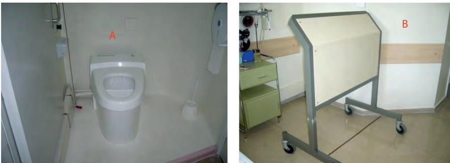
**Figura 11.** Aseo radioprotegido (A) y mampara (B) empleados en habitaciones radioprotegidas.
