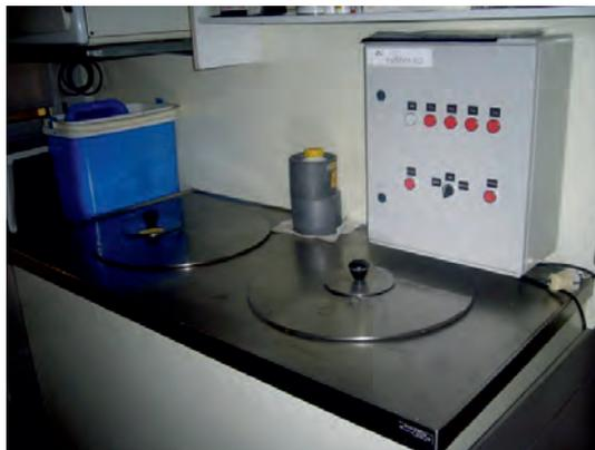
**Figura 5.** Pozo de residuos líquidos con el equipo para su vertido controlado.
