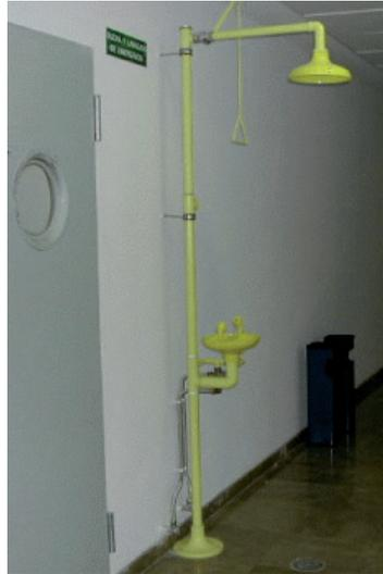
**Figura 4.** Ducha de descontaminación de personal de operación.
